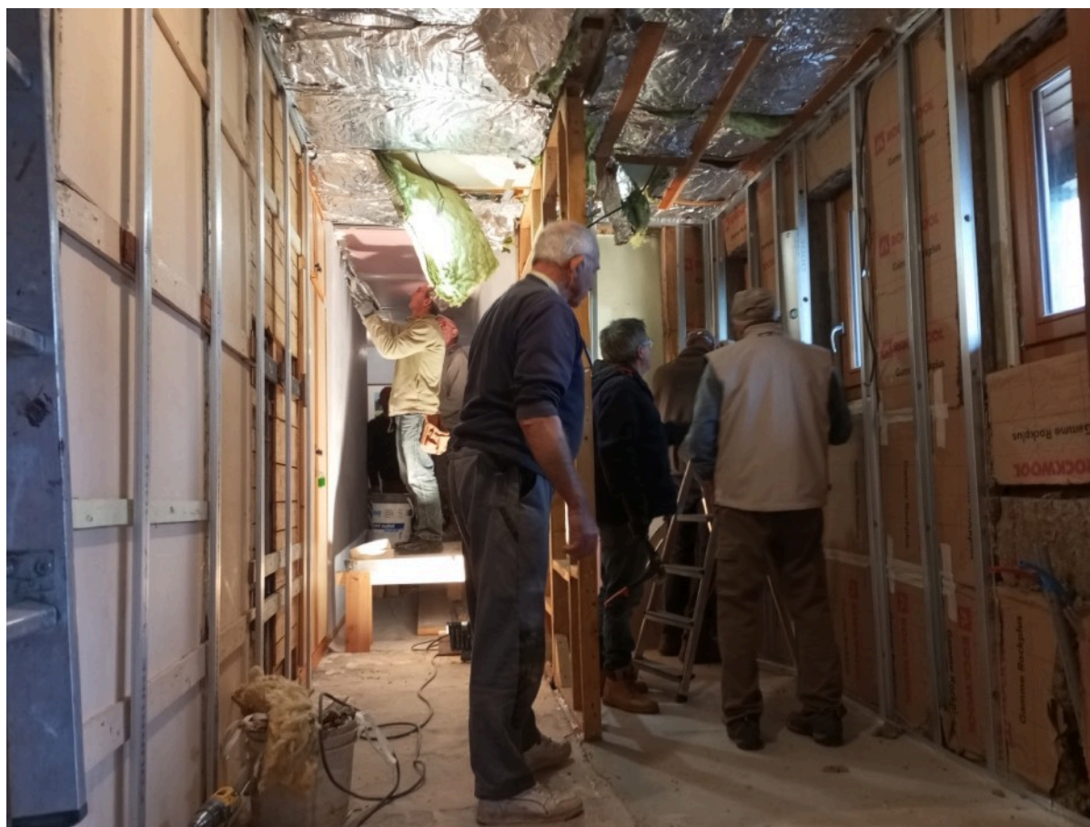
Isolation de la paroi extérieure et structure de la cloison
