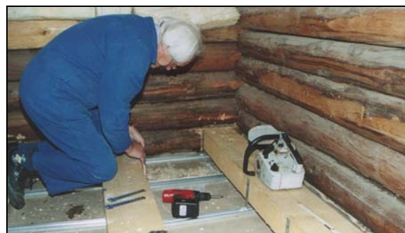
Travaux au refuge DR
